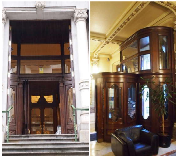
Acceso central y puerta giratoria, zona interna y externa
