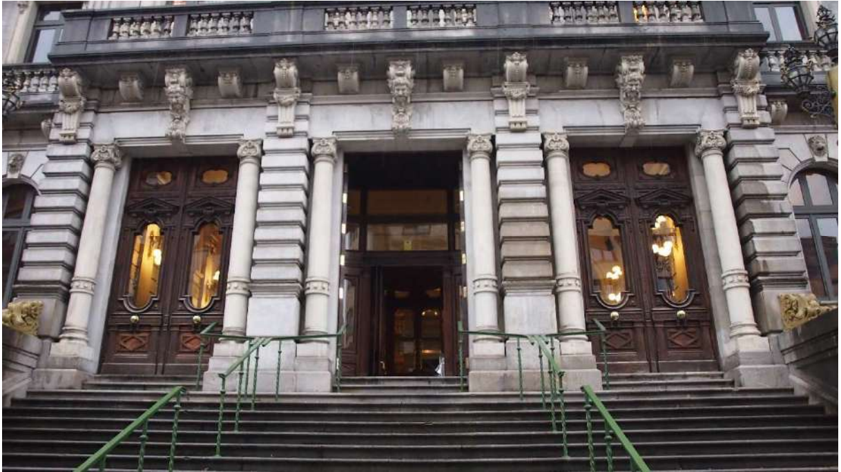
Vista general acceso principal y puertas laterales
