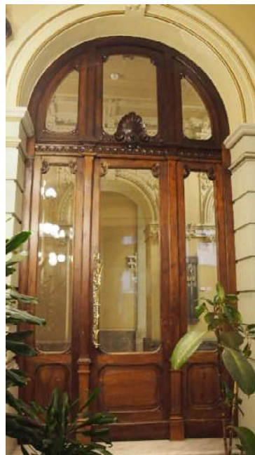
Detalle puertas acceso interno
