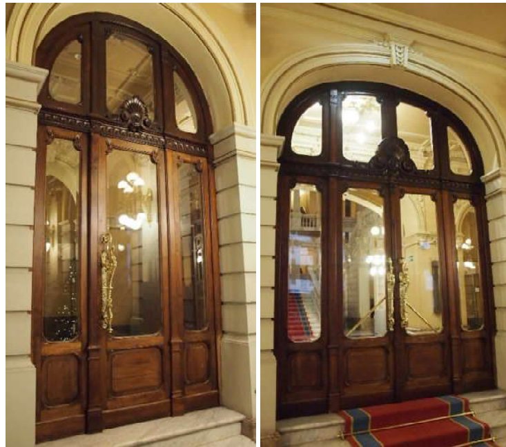
Detalle puertas acceso interno
