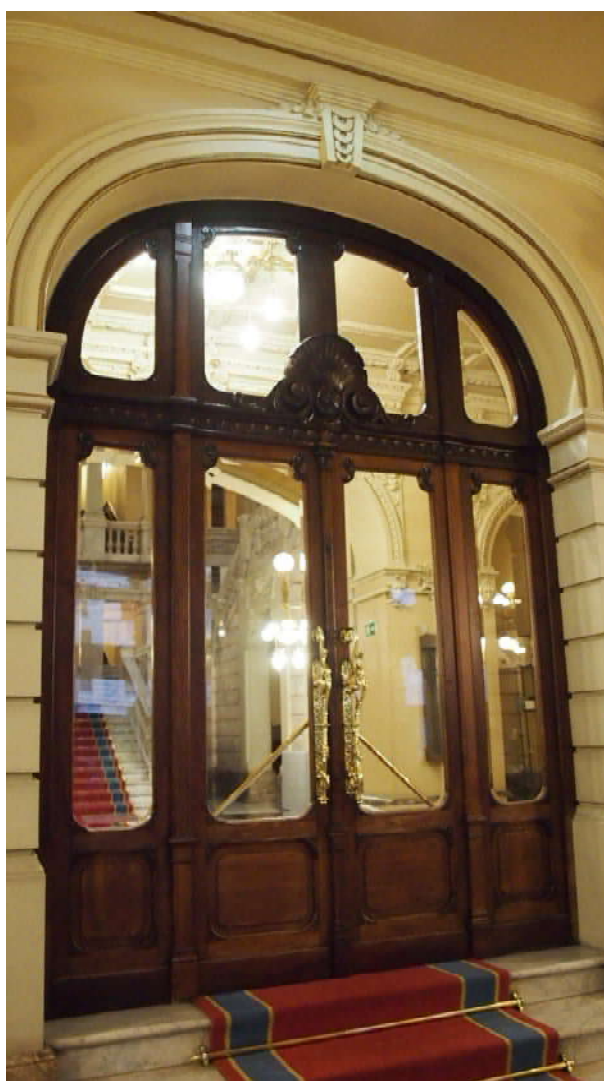
Puerta zona interna
