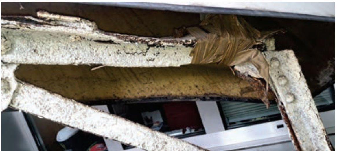
Aspecto inicial de la cercha (previa a retirada de pintura semidesprendida)
