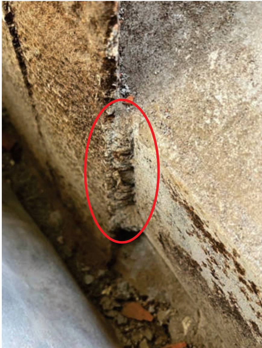
Soldadura entre angular y ménsula
