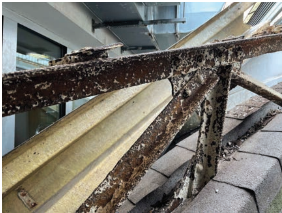
Oxidación generalizada
