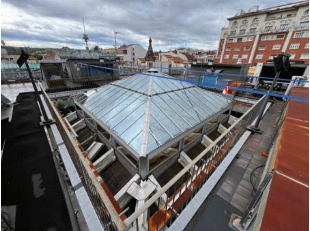
Vista general del lucernario y las ménsulas con sus protecciones
