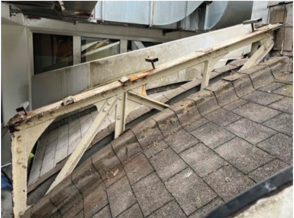
Vista de estado actual de las ménsulas
