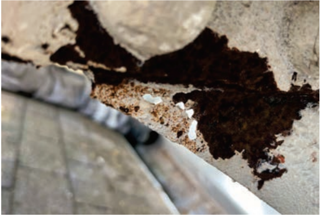
Rotura de perfiles
