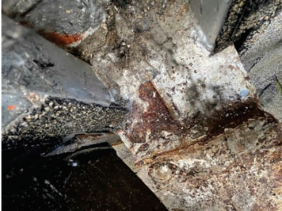
Oxidación en unión con lucernario
