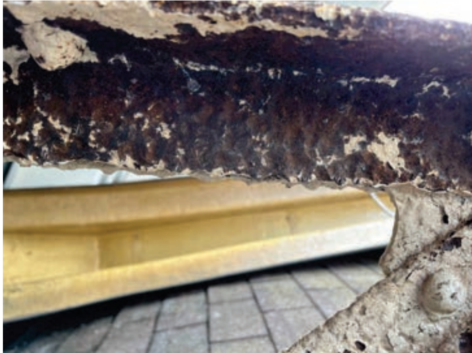
Oxidación por picaduras tras retirada de la pintura con cepillo de alambre
