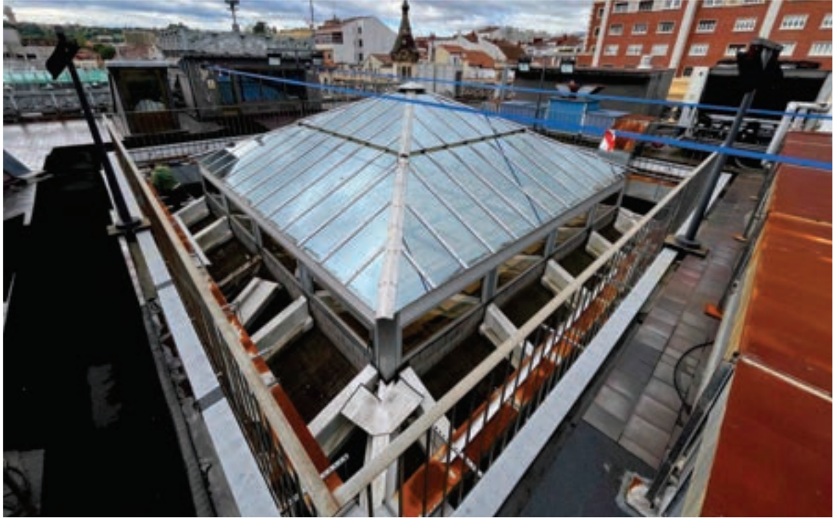
Lucernario y ménsulas de apoyo protegidas con cobertura de fibra.
