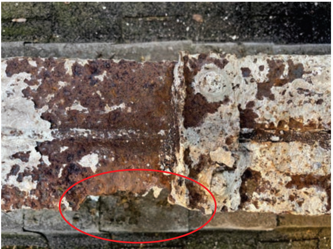
Rotura de perfiles
