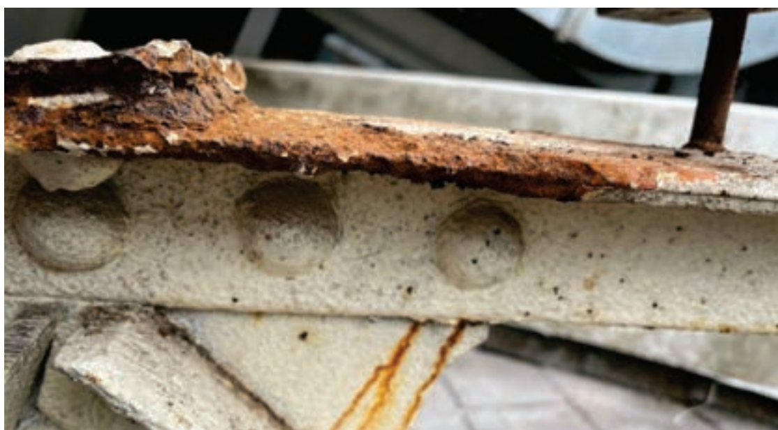
Oxidación moderada en ala superior de perfil
