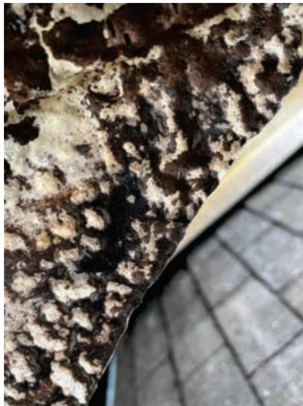
Oxidación por picaduras tras retirada de la pintura con cepillo de alambre
