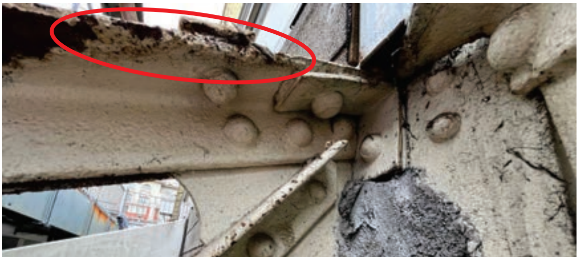
Perdida sección borde perfil
